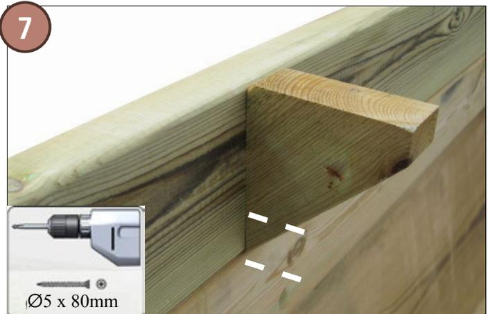
Die Holzkeile dienen der Abstützung des Handlaufs, der nach Befüllen des Beckens montiert wird. Bohren Sie die Wand von der Innenseite des Beckens her an; befestigen Sie dann die Holzkeile (Typ I) mit je zwei Schrauben (5x100 mm, Pack J). Achten Sie darauf, dass sie bundig unter der Beckenoberkante zu liegen kommen. Entfernen Sie alle angefallenen Holzsplitter.
