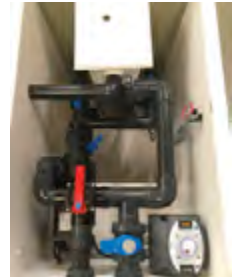
Bypass Stellung ohne Nutzung einer Wärmepumpe.
